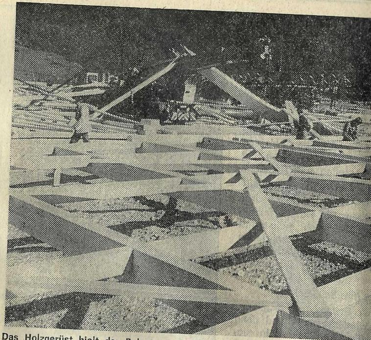
Das Holzgerüst hielt der Belastung durch die Dachkonstruktion nicht stand.
