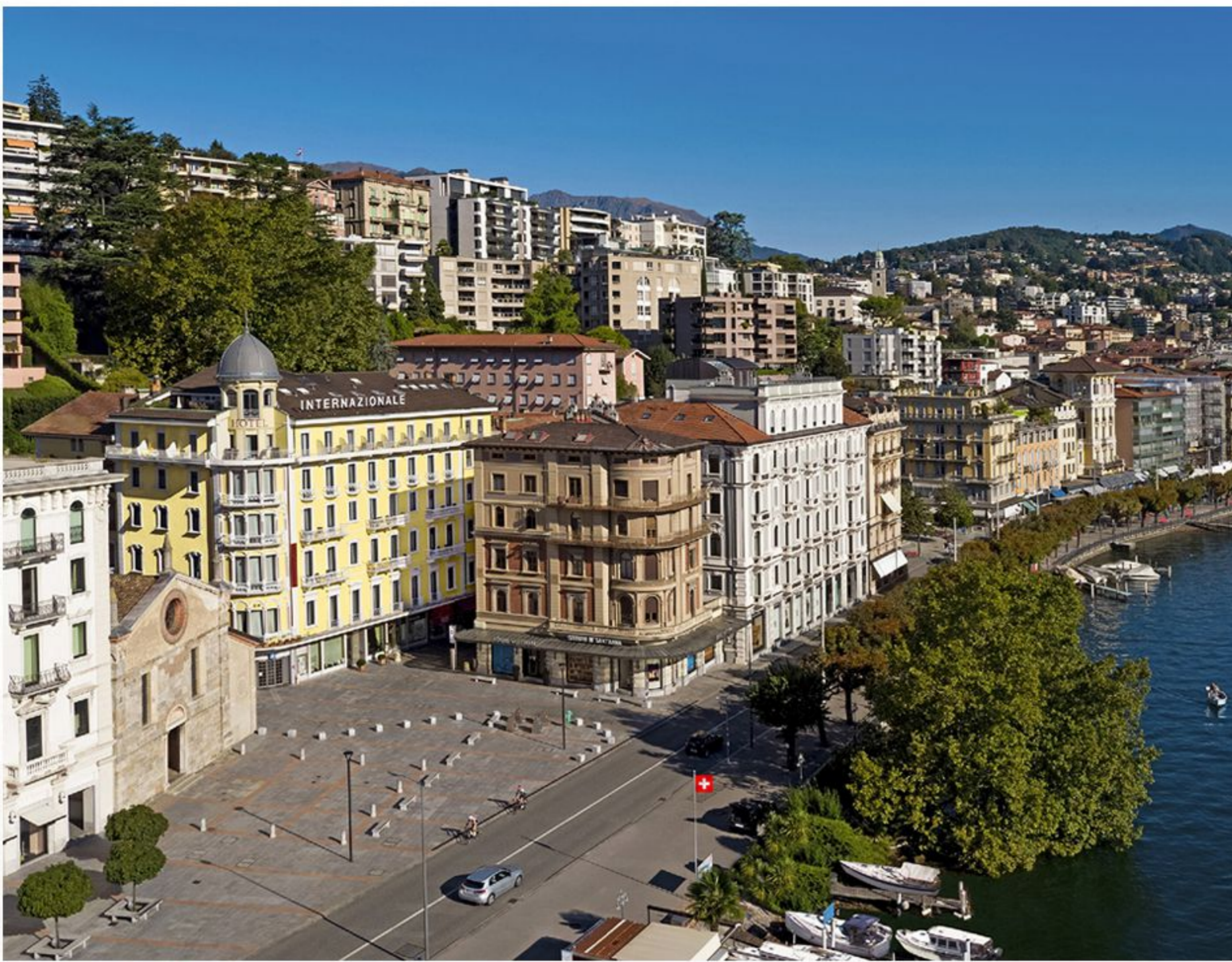
Ansicht des frisch renovierten Hotel International im Sommer 2020.
